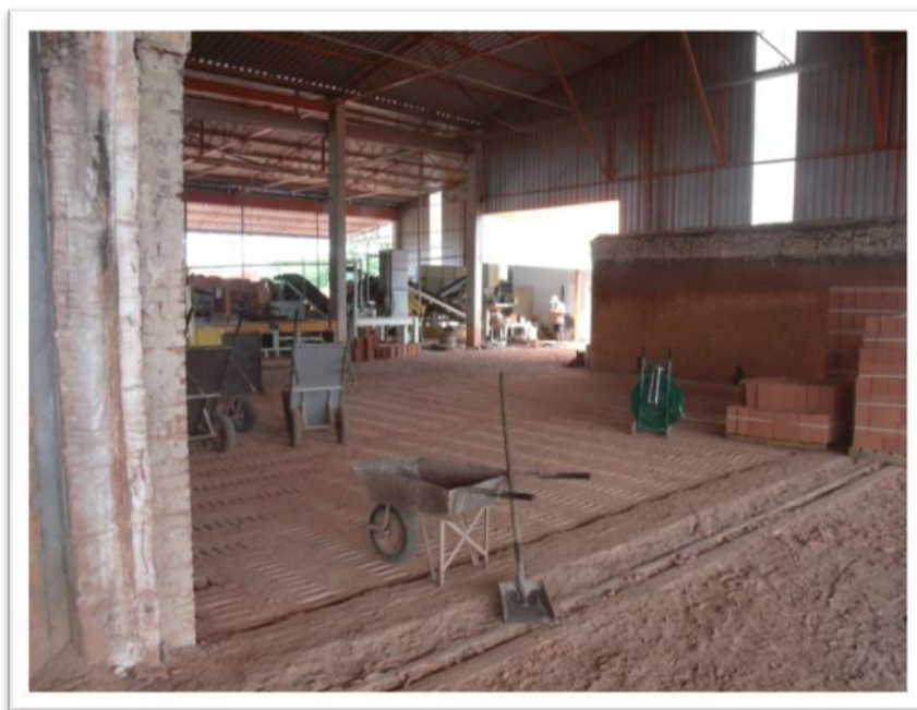
Figura 16: Vista do Forno Túnel sobre Trilhos Descarregado.
