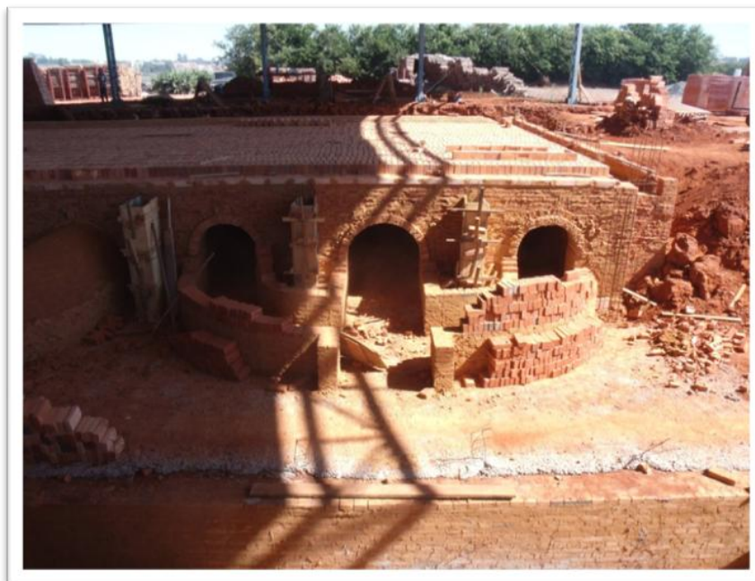
Figura 12: Forno Abóboda sendo Construído. E suas galerias para recirculação do ar quente
