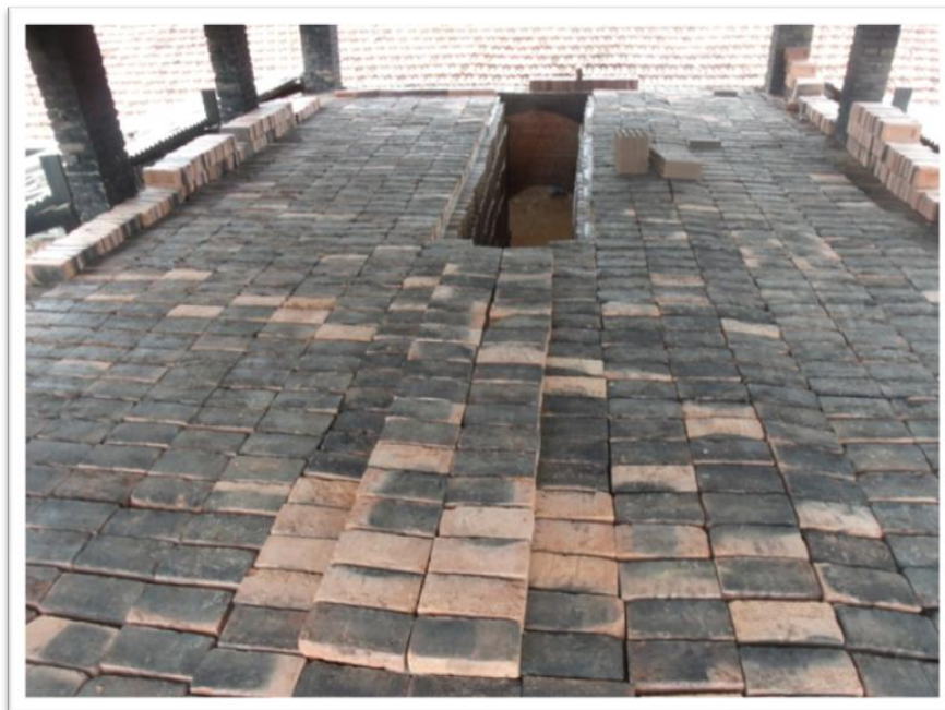
Figura 9: Vista Superior do Forno de Chama Direta. Sendo Fechado para Evitar Perda de Calor
